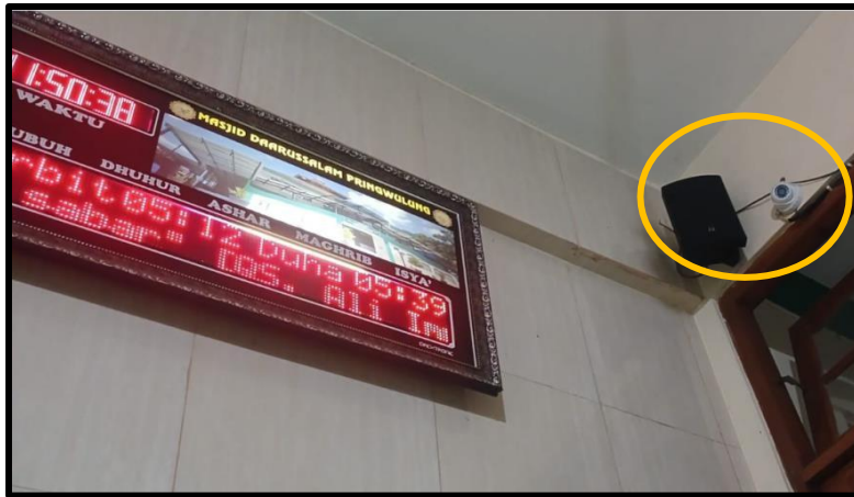
Gambar 6. Pemasangan Kamera CCTV di Ruang Utama Masjid
