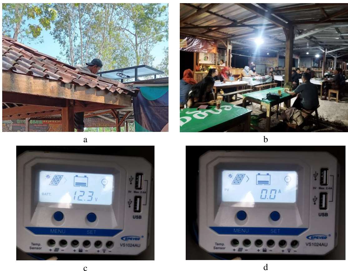
Gambar 6. Sistem PLTS Terpasang, a. Solar Panel Diatas Atap b. Penampakan Cahaya Malam dari Lampu, c. Tegangan sesaat baterai, d. Arus PV sebelum matahari terbit,
